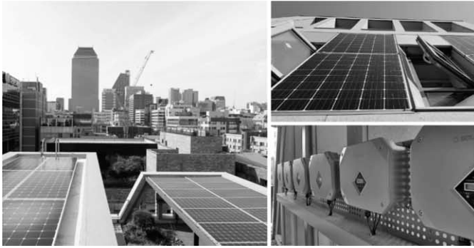
[그림 29] 옥상과 외벽 태양광 패널
