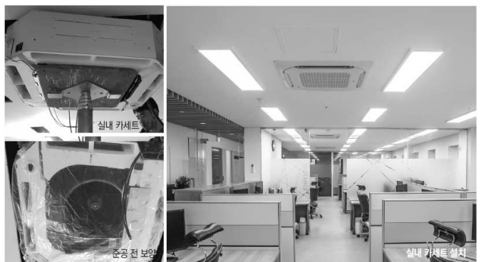
[그림 19] EHP 공사
