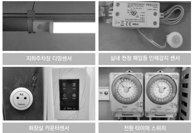
[그림 25] 다양한 에너지절감 센서 적용
