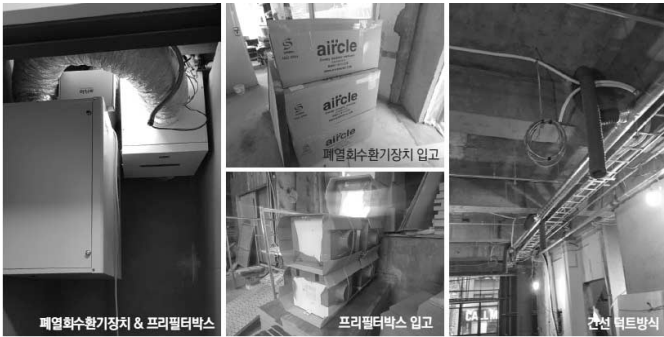
[그림 20] 폐열회수환기장치 시공
