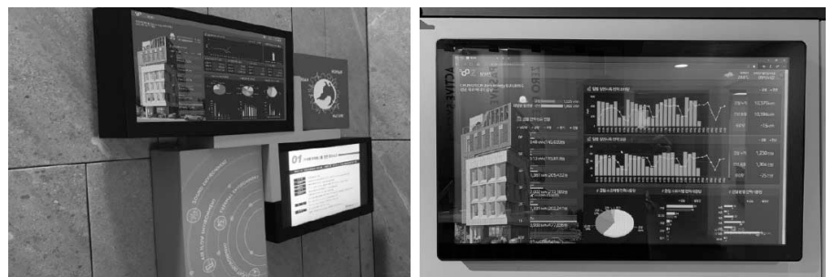
[그림 28] EV홀 및 6층 복도의 BEMS 모니터
