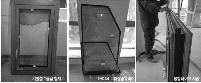
[그림 12] 패시브 창호 시공
