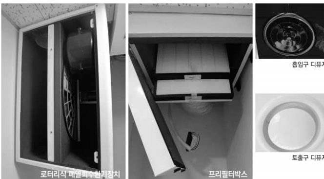
[그림 22] 폐열회수환기장치 설치 결과
