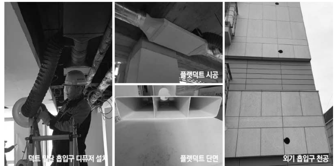
[그림 21] 폐열회수환기장치 덕트 시공
