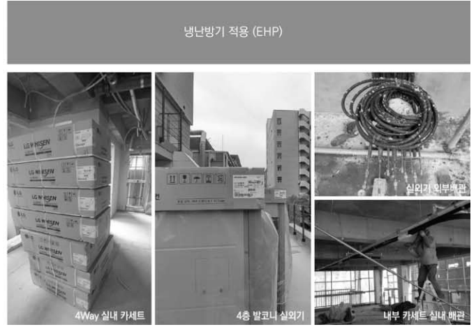
[그림 17] EHP 구성을 위한 기기
