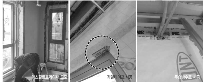
[그림 13] 기밀성 확보 시공
