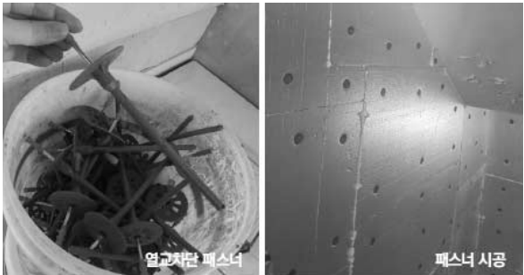
[그림 8] 열교차단 패스너 시공
